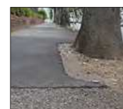
補修工事された歩道
